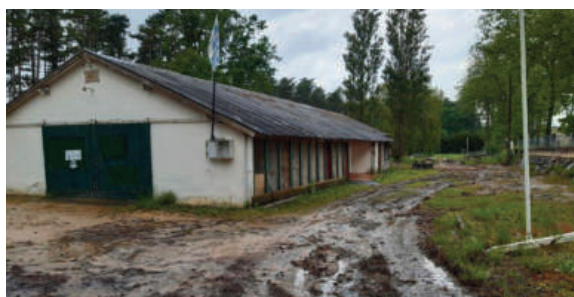
Anciens locaux de la base nautique démolis
