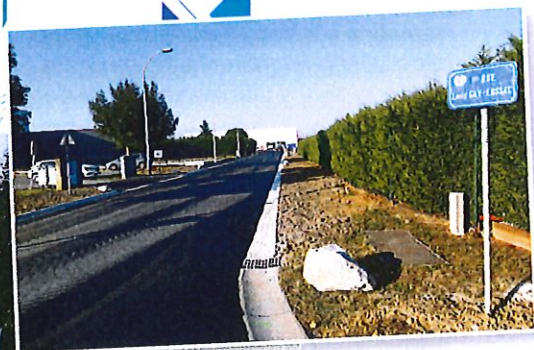
Travaux rue Gay Lussac
