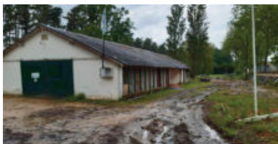
Anciens locaux de la base nautique démolis
