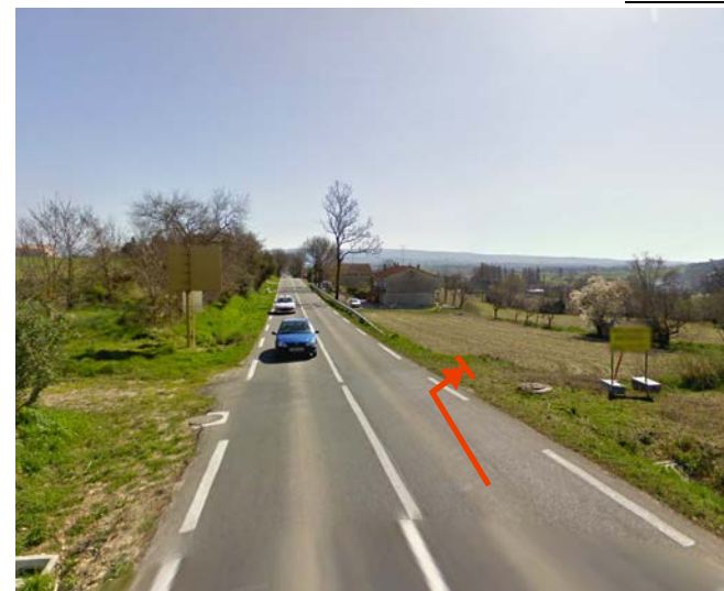
Accès depuis la RD n°1
