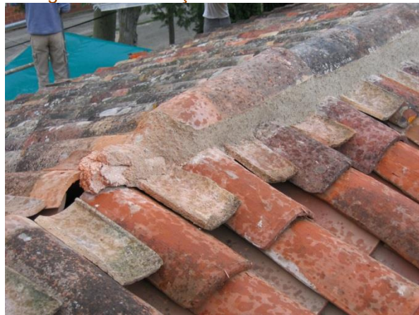
Faîtage et arêtier maçonnés avec casseaux sur le dernier rang
