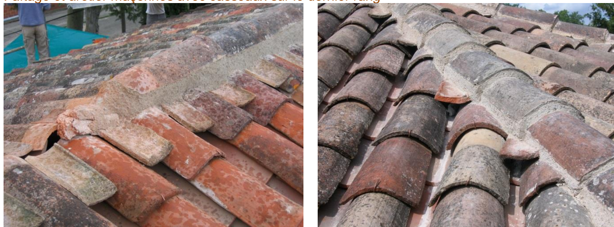
Faîtage et arêtier maçonnés avec casseaux sur le dernier rang
