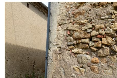
Bandeau vertical d'une chaîne d'angle recouvert d'un badigeon blanc (Labruguière, Tarn).
