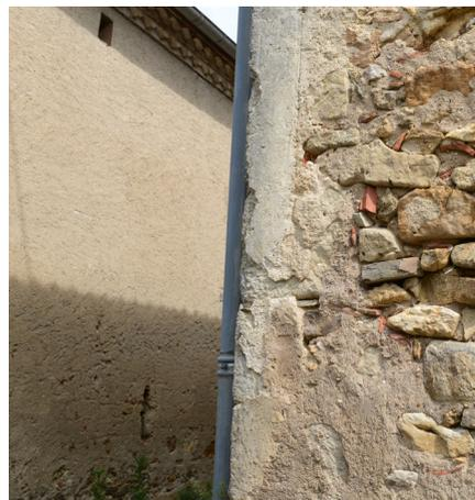
Chaîne d'angle harpé avec une variation dans l'enduit, il reste quelque trace de badigeon sur le harpage, le bandeau et la génoise (Revel).
