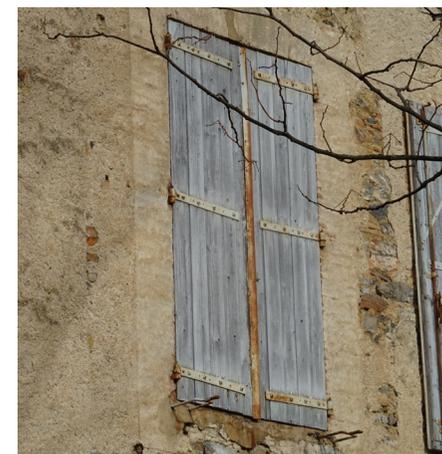
Encadrement en brique masqué par un enduit lissé, la coupure de l'enduit demeure droite (Revel).
