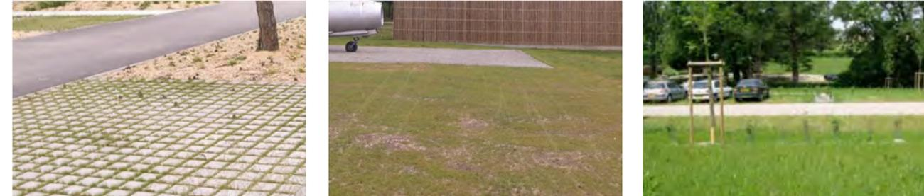
*Sationnements fréquents sur stabilisé renforcé ou pavés enherbés. Sationnements occasionnels concassés enherbés*
