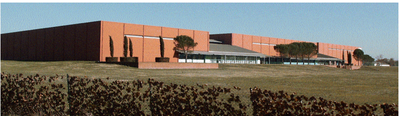
Teinté d'une couleur locale (ci-dessus la brique), accompagné d'essences régionales (cyprés et pin pignon) et doté d'abords généreusement traités, cet équipement industriel est capable de s'intégrer au territoire dans lequel il s'inscrit - Villefranche de Lauragais.
