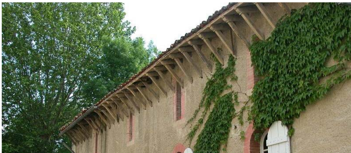
Corbeaux en bois
