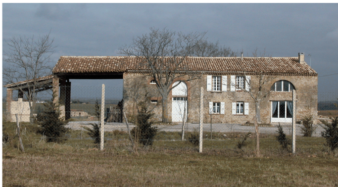
Aménagement des deux niveaux d'une ferme. La composition originale n'a pas été touchée. Attention cependant à la peinture blanche qui donne beaucoup d'importance aux volets, menuiseries et remplissage des baies - Césalles.
