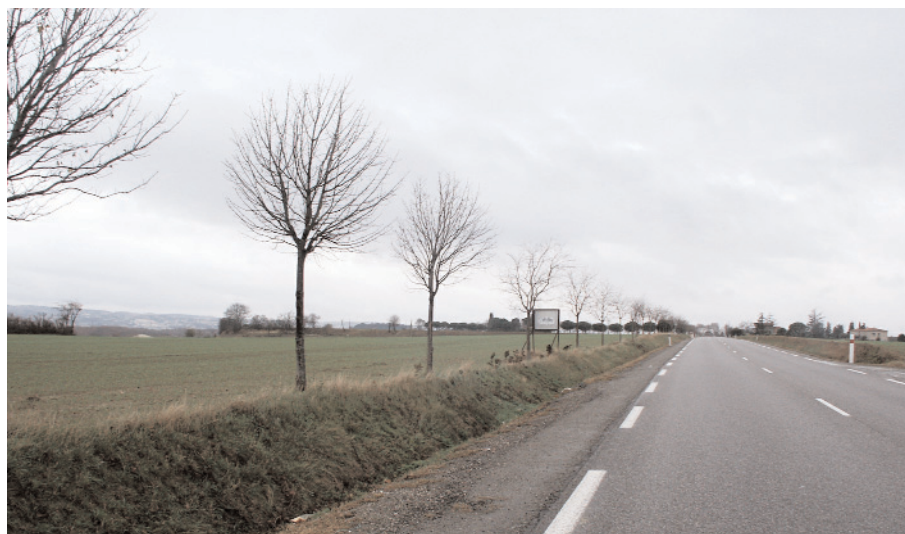
exemple de traitement récent d'une route départementale
