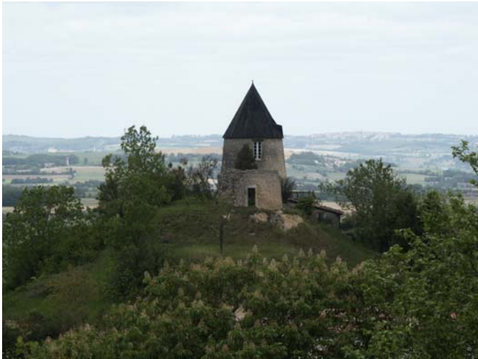
Moulin réhabilité à St Félix
