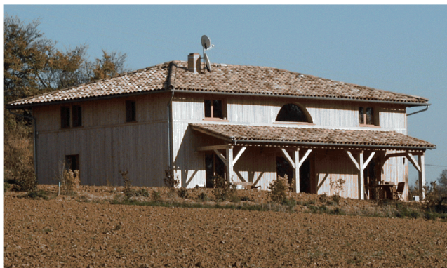
Maison isolée sur une crête - St Michel de Lanès Outre ses qualités mécaniques et esthétiques, la construction en bois (hormis les colombages et les hangars agricoles) n'appartient pas à la tradition du Lauragais et s'associe désormais à l'architecture internationale. Ci-dessus la volumétrie proposée n'est pas issue des données locales : toiture à quatre pentes et auvent sur piliers.
