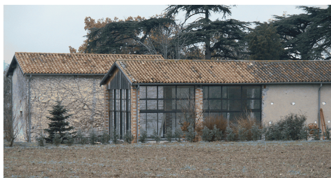
Fermeture vitrée d'un hangar : légèreté et respect du volume d'origine - Revel
