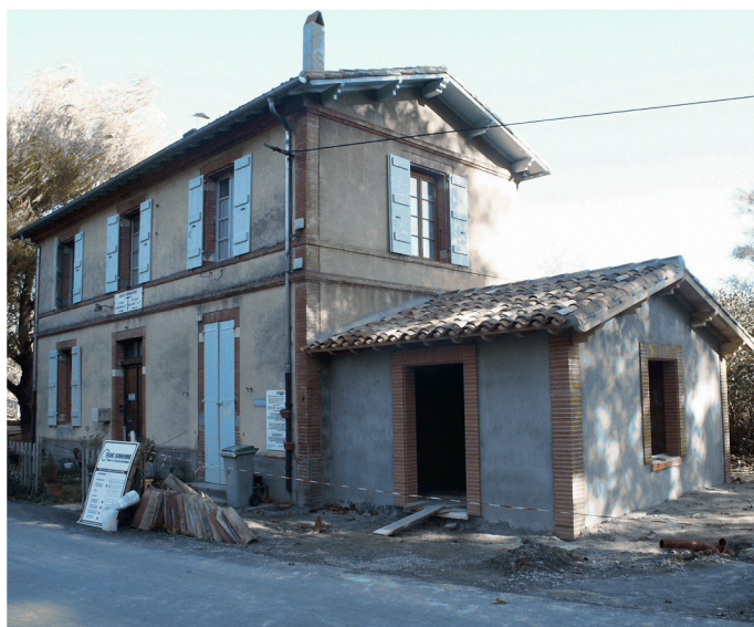
Extension d'une maison d'éclusier à Ayguesvives
