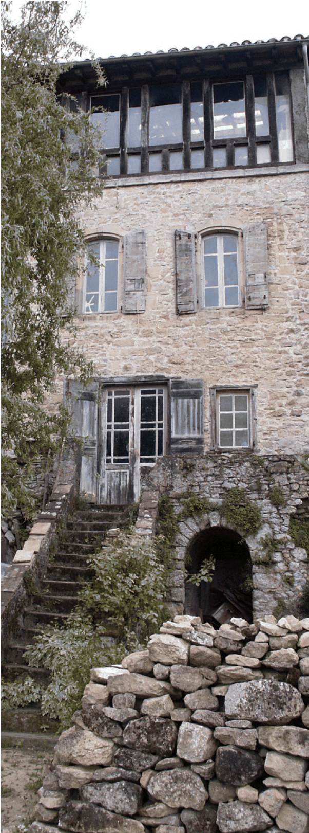
Eclairage naturel d'un atelier à travers les colombages - St Félix
