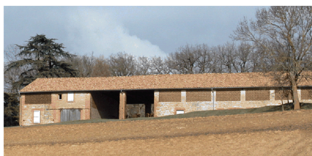
Horizontalité du bâti agricole rythmé par des piliers verticaux Césalles
