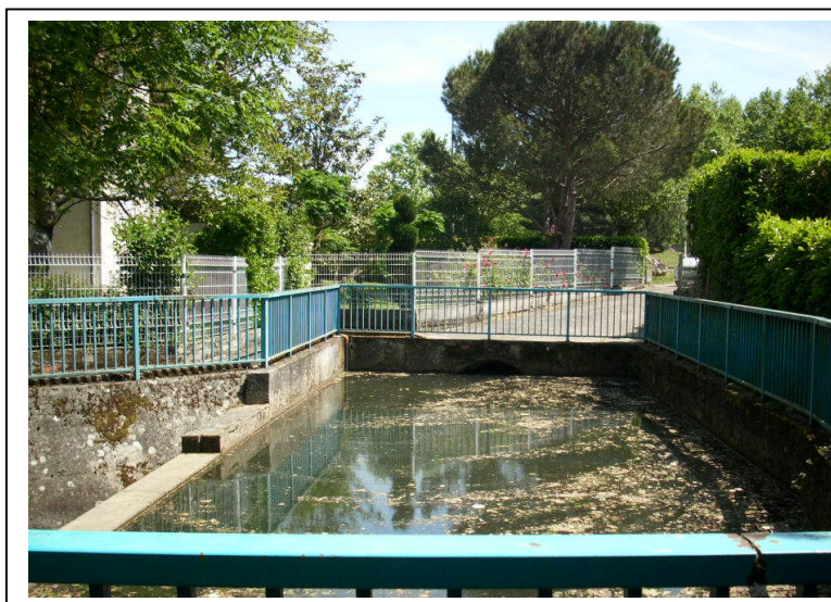
Ouvrage de répartition
