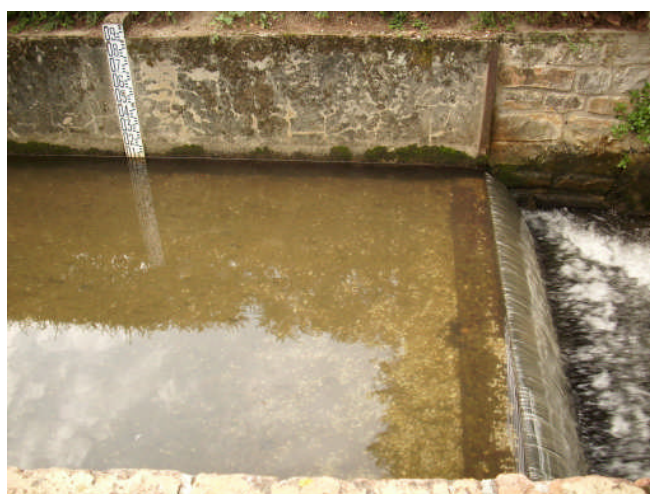
Seuil de Labardoque
