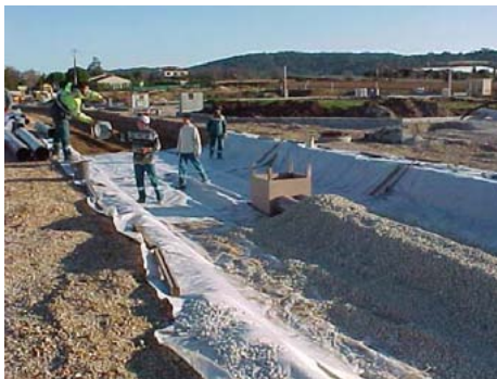
Préparation de la structure-réservoir Source DDT
