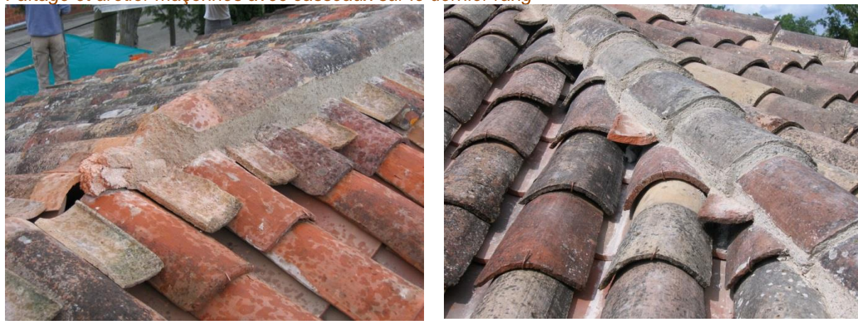
Faitage et arêtier maçonnés avec casseaux sur le dernier rang
