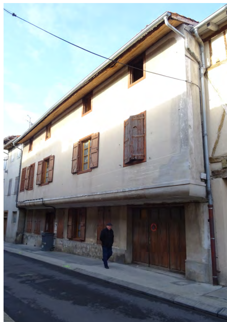
Maison à simple encorbellement 5 rue du Taur.
