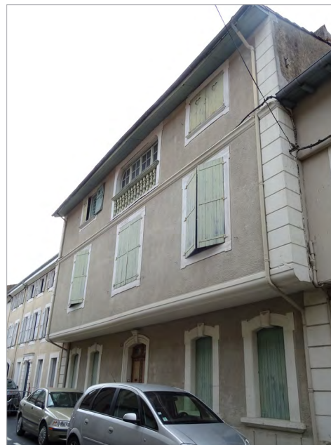
Maison à simple encorbellement 10 rue Georges Sabo.
