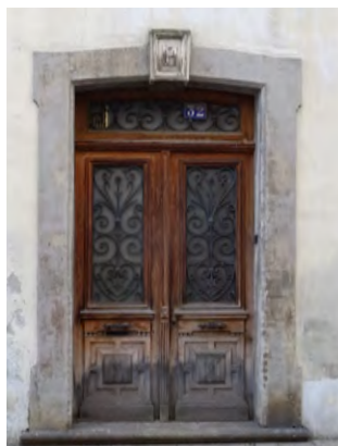
2. Les panneaux en pointe de diamant, les portes vitrées avec grilles de protections sont caractéristiques des menuiseries de la fin du XIXe siècle.
