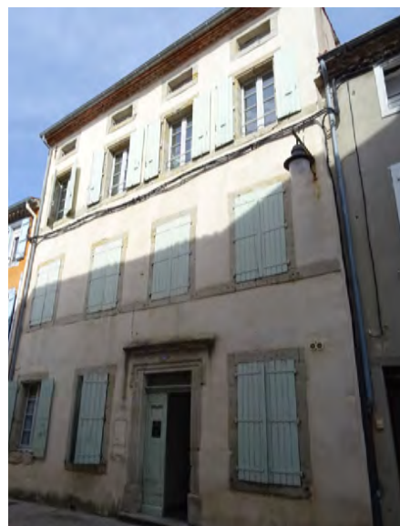
Maison au n°25, rue Jean Moulin.
