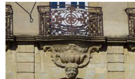
Seuil mouluré courbe, encorbellement pittoresque et balconnet en fer forgé. n°06, Galerie du Nord.
