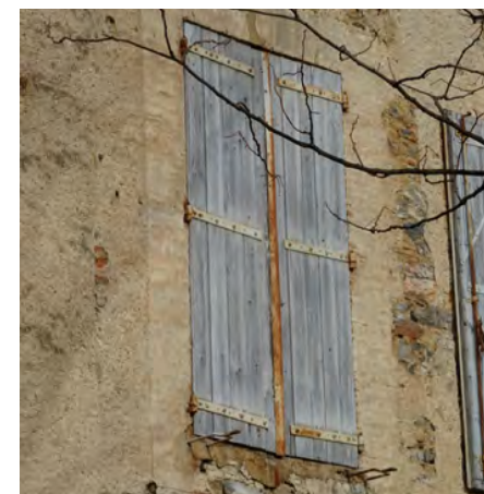
Encadrement en brique masqué par un enduit lissé, la coupure de l'enduit demeure droite (Revel).
