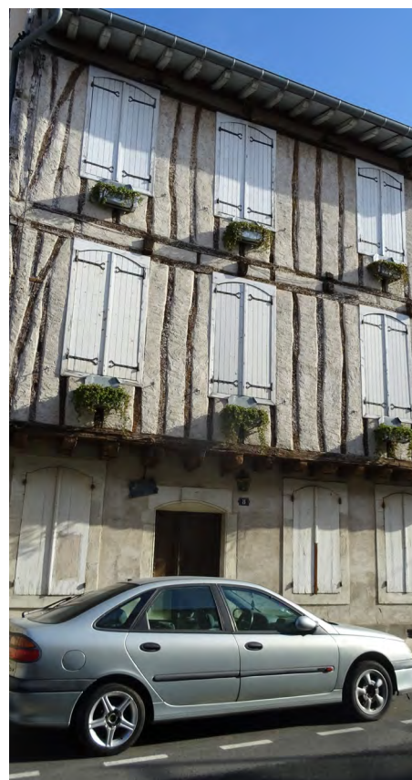
Maison à pan de bois avec un encorbellement, probablement avec modification d'un édifice antérieur. rue du Temple
