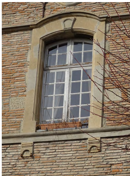
Maison au n°01, Galerie du Couchant. Menuiseries ouvrant à la française avec petits carreaux. La menuiserie est redécoupée par une traverse d'imposte.
