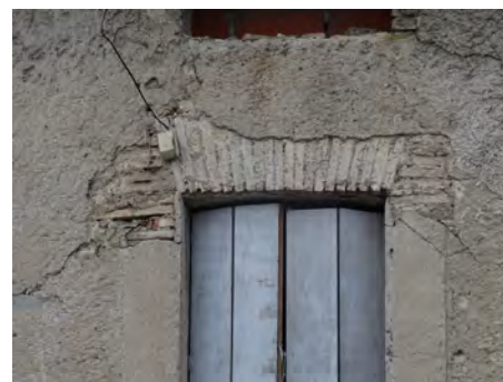
Encadrement en brique masqué par un enduit pour imiter la pierre.
