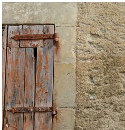
Coupure droite de l'enduit pour délimiter l'encadrement en pierre (Labruguière, Tarn).
