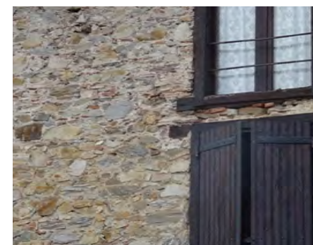
Maçonnerie de moellons de pierre
