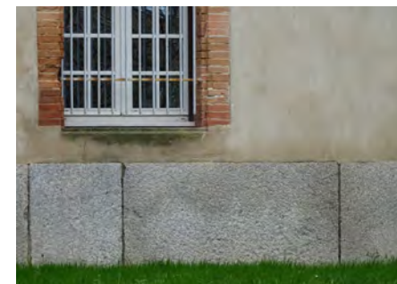
Soubassement en granit
