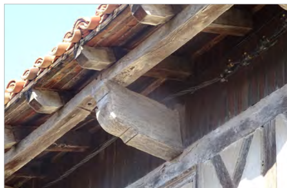
Débord avec sablière en encorbellement soutenue par des poutres – maison à Touget dans le Gers.
