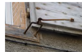
Le contrevents à cadre avec penture en cœur et arrêt « annulaire » est le modèle le plus répandu durant tout le XIXe siècle.
