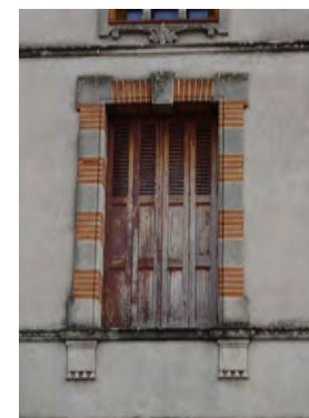
Le contrevents à cadre avec penture en cœur et arrêt « annulaire » est le modèle le plus répandu durant tout le XIXe siècle.
