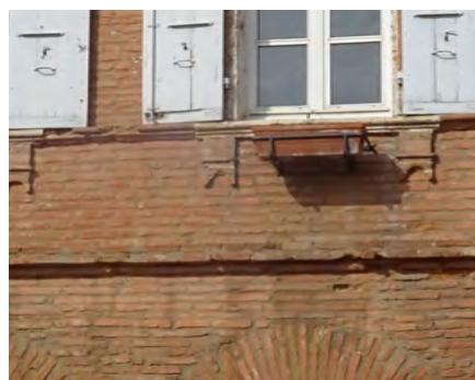
Maçonnerie de briques foraines
