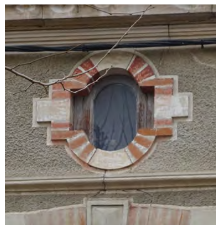
Décor de listel blanc cassé autour des encadrements, cordons et corniche. Les briques reçoivent un badigeon ocre rouge et les joints sont redessinés.
