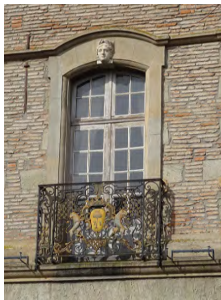
Maison au n°01, Galerie du Couchant. Menuiseries ouvrant à la française avec petits carreaux. La menuiserie est redécoupée par une traverse d'imposte.
