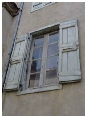
Le contrevents à cadre avec penture en cœur et arrêt « annulaire » est le modèle le plus répandu durant tout le XIXe siècle.
