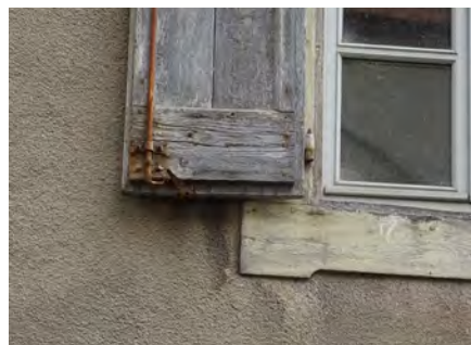
Encadrement en bois avec couvre-joint
