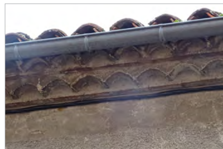
Génoise et bandeau recouvert d'un badigeon blanc.
