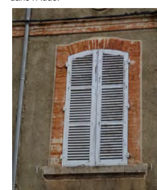
Contrevents se rabattant dans l'ébrasement, ce dispositif est courant dans l'Aude.
